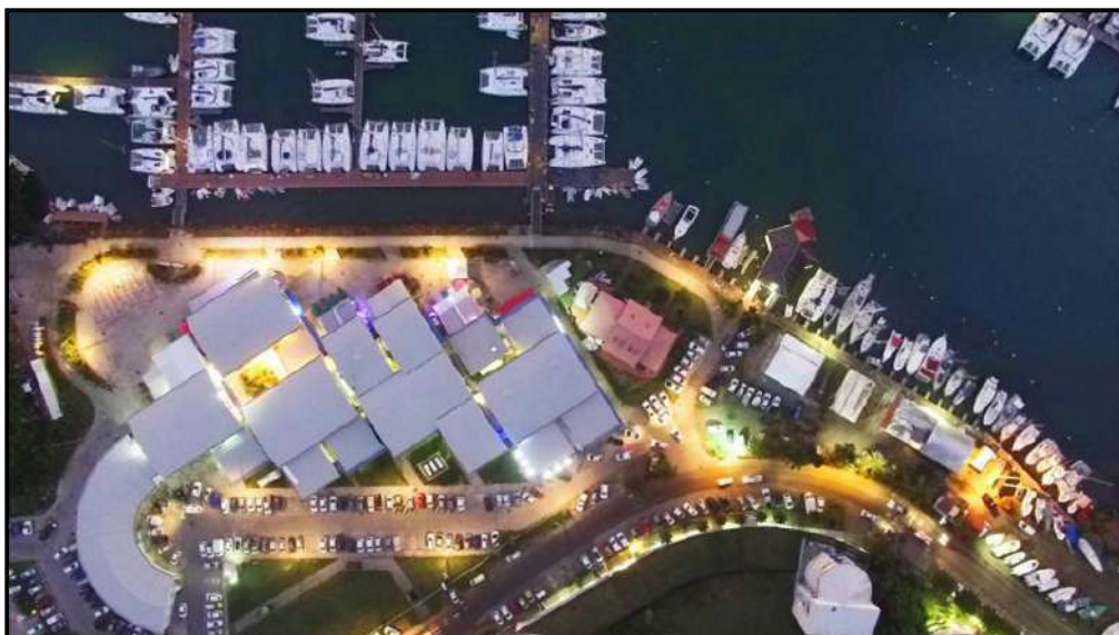
Figure 54 : Eclairages LED de la Marina du Marin
